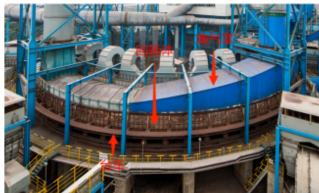
图1 水密封环冷机
